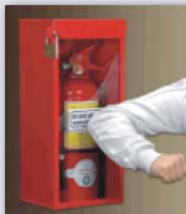
Forma NO recomendada para romper el vidrio.
