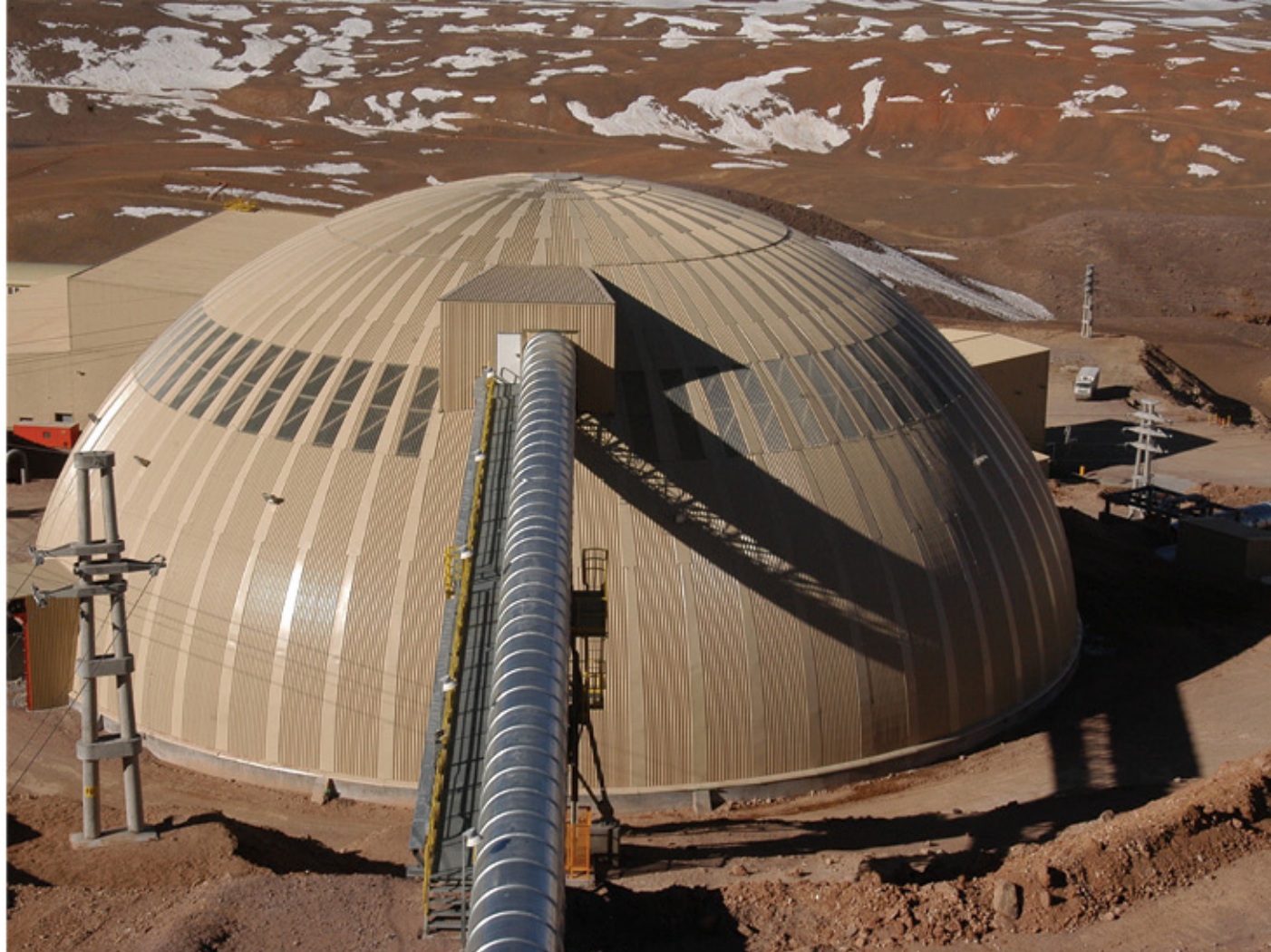
Instalaciones de la mina de oro a cielo abierto en Veladero, Provincia de San Juan, Argentina, a 4000 metros sobre el nivel del mar. En su construcción trabajaron 1200 personas.
