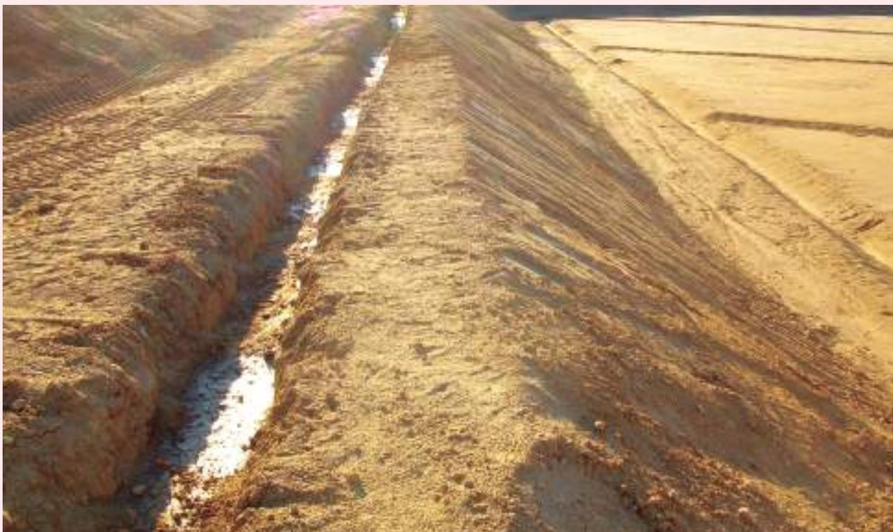
nas, camiones, etc. que supongan una sobrecarga, así como la existencia de tráfico rodado que transmita vibraciones que puedan dar lugar a desprendimientos de tierras en los taludes, se adoptarán las medidas oportunas de refuerzo de entibaciones, balizamiento y señalización de las diferentes zonas.
