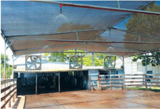
**EJEMPLO DE SUBSOMBREADO CON VENTILACIÓN FORZADA Y HUMIDIFICACIÓN POR LLUVIA**
